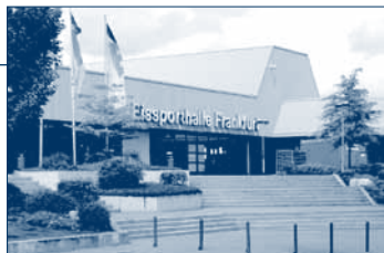
Eissporthalle , Nähe Buchwaldstraße
